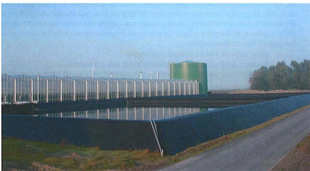
Figuur 2.2: Voorbeeld van een hemelwaterbassin
