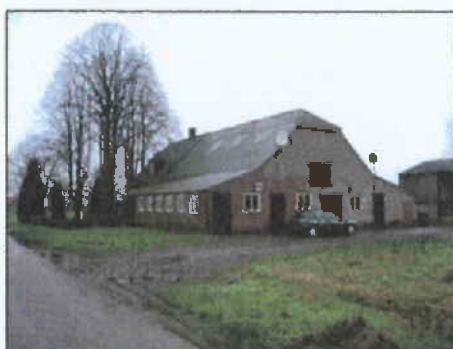
Foto 1: Stal met betonplaten
