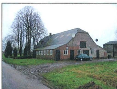
Foto 1: Stal met betonplaten
