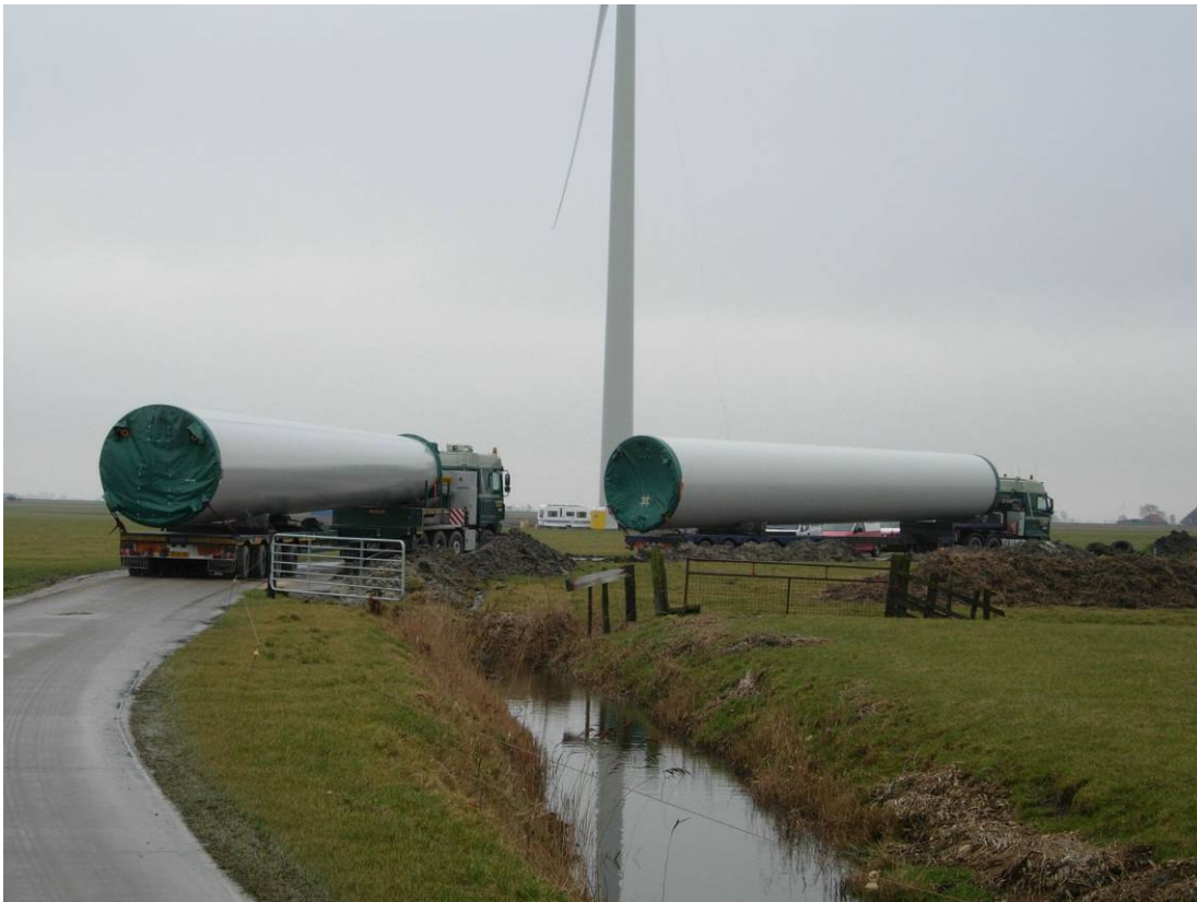
Figuur 3.5 Transport onderdelen van de mast
