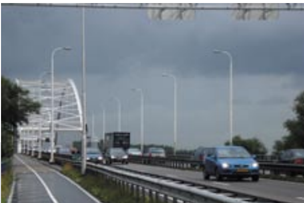
Figuur 2: A27 ter hoogte van de brug bij Gorinchem
