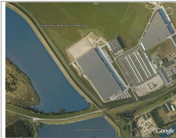
situering van bedrijven parallel aan de dijk
