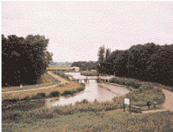
Brug over de Ringvaart
