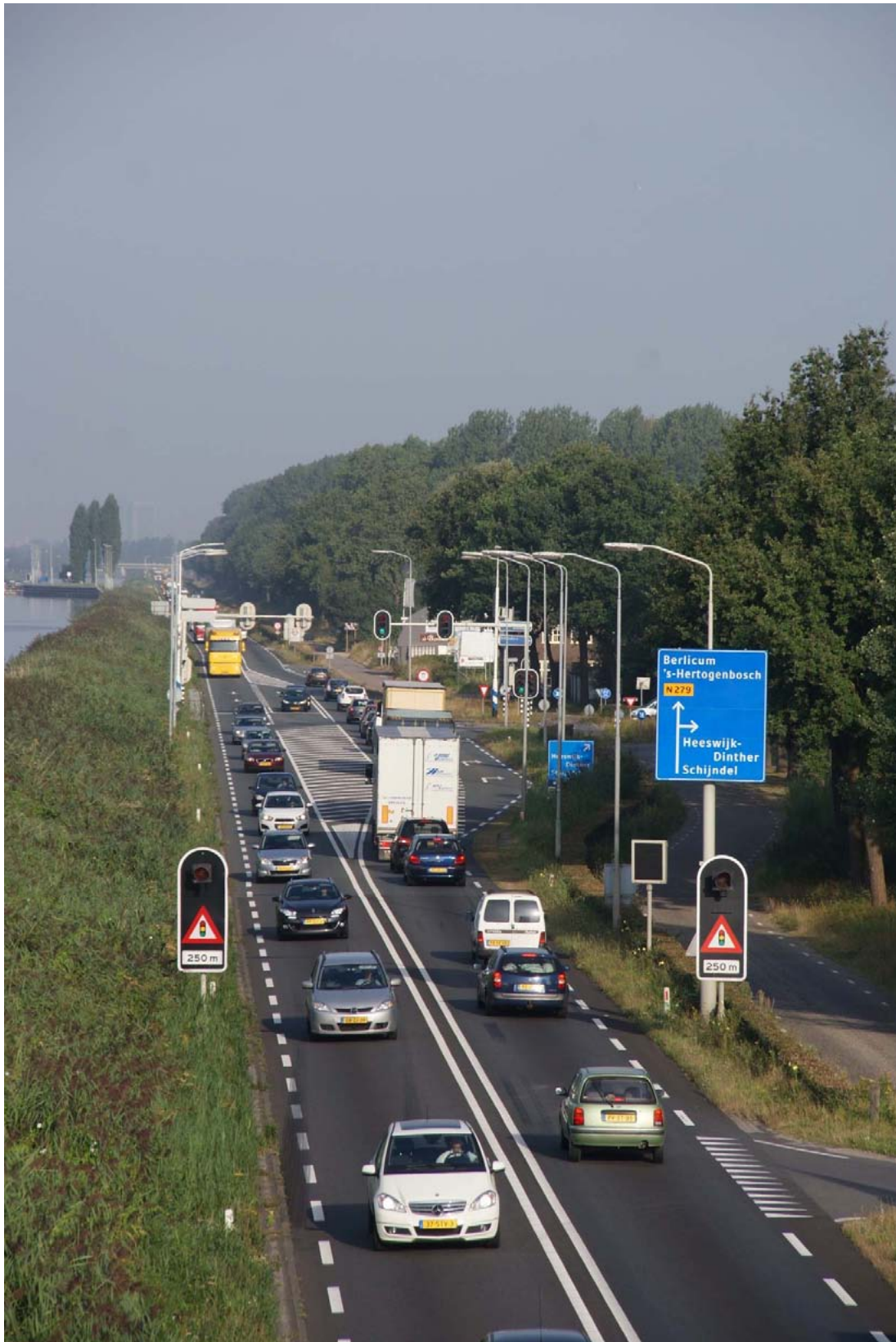
Afbeelding 3.21: Huidige situatie ter hoogte van Heeswijk Dinther (opname werkdag aug. 2012)
