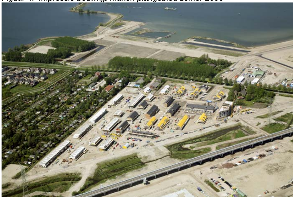
Figuur 4. Impressie bouwrijp maken plangebied zomer 2006
