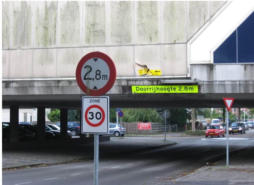
Afbeelding 4.1. Onderdoorgang in de Pa Verkuyllaan 1
