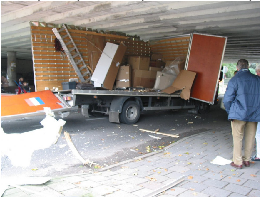
Afbeelding 5.4. Vastgereden vrachtwagen, viaduct over de Sloterweg 4
