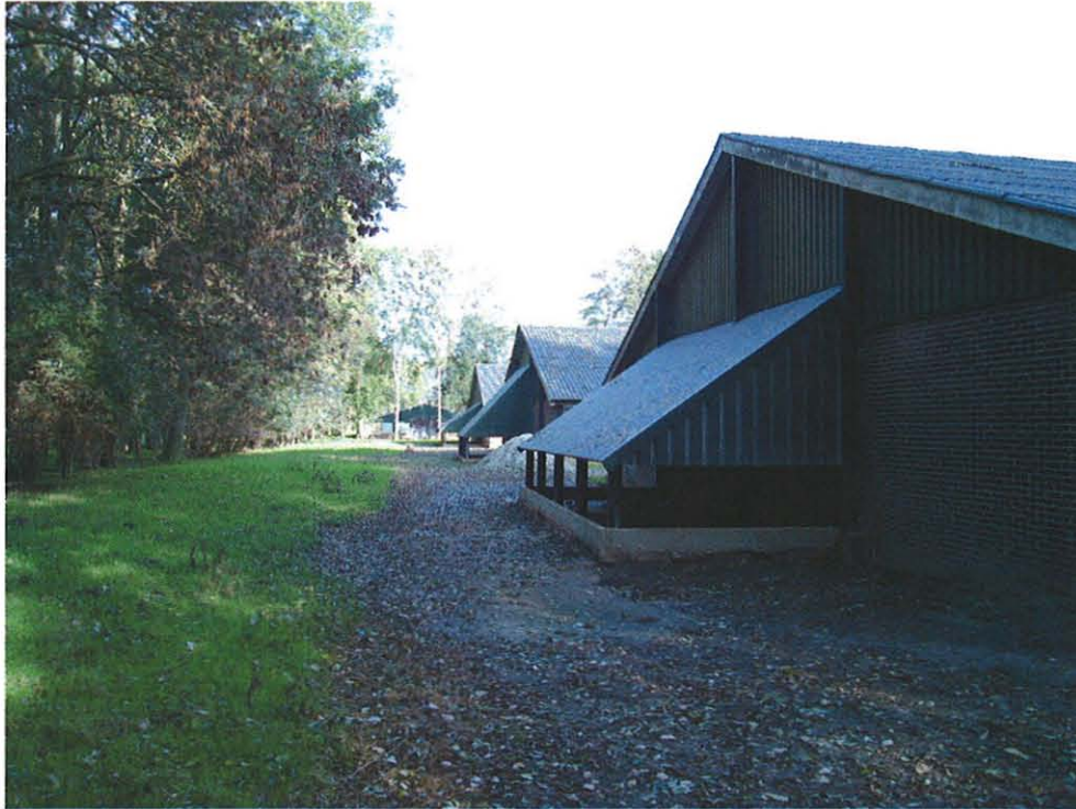
Figuur 5.2 Stofkappen achter de ventilatoren van de bestaande stallen H t/m N
