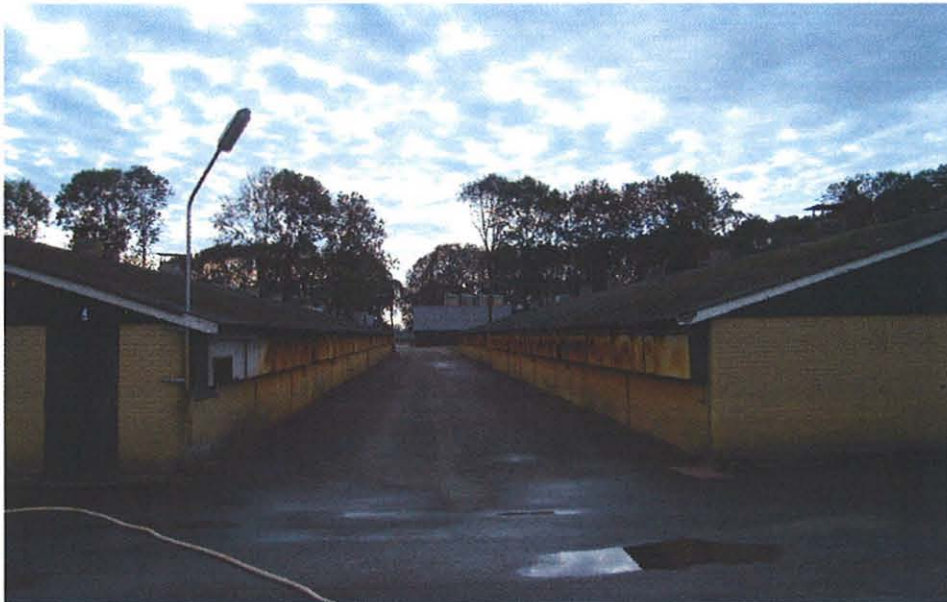
Figuur 4.1 Foto van de bestaande stallen welke gesloopt zullen worden
