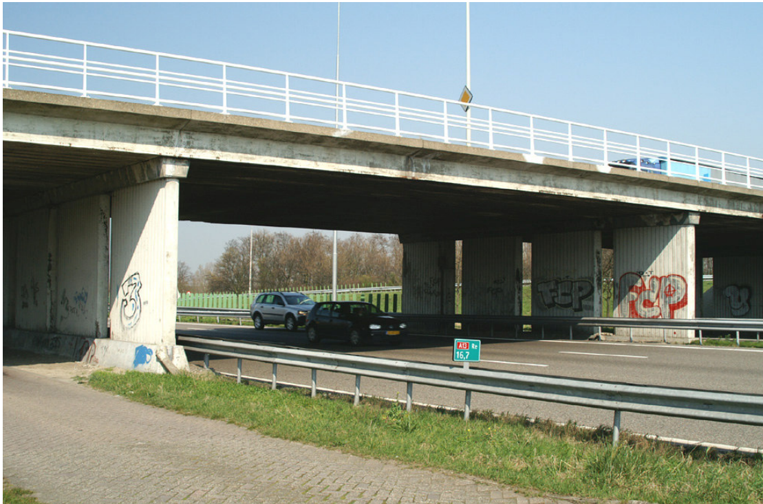
Figuur 2.1 Bestaande kunstwerk in N209 over A13
