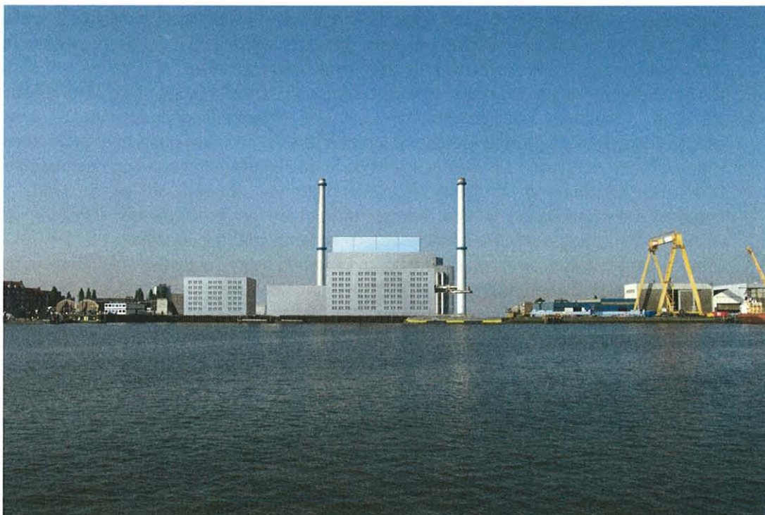
Figuur 6.1: Zicht op Retrofit-2 AVR Brielselaan vanaf Katendrecht
