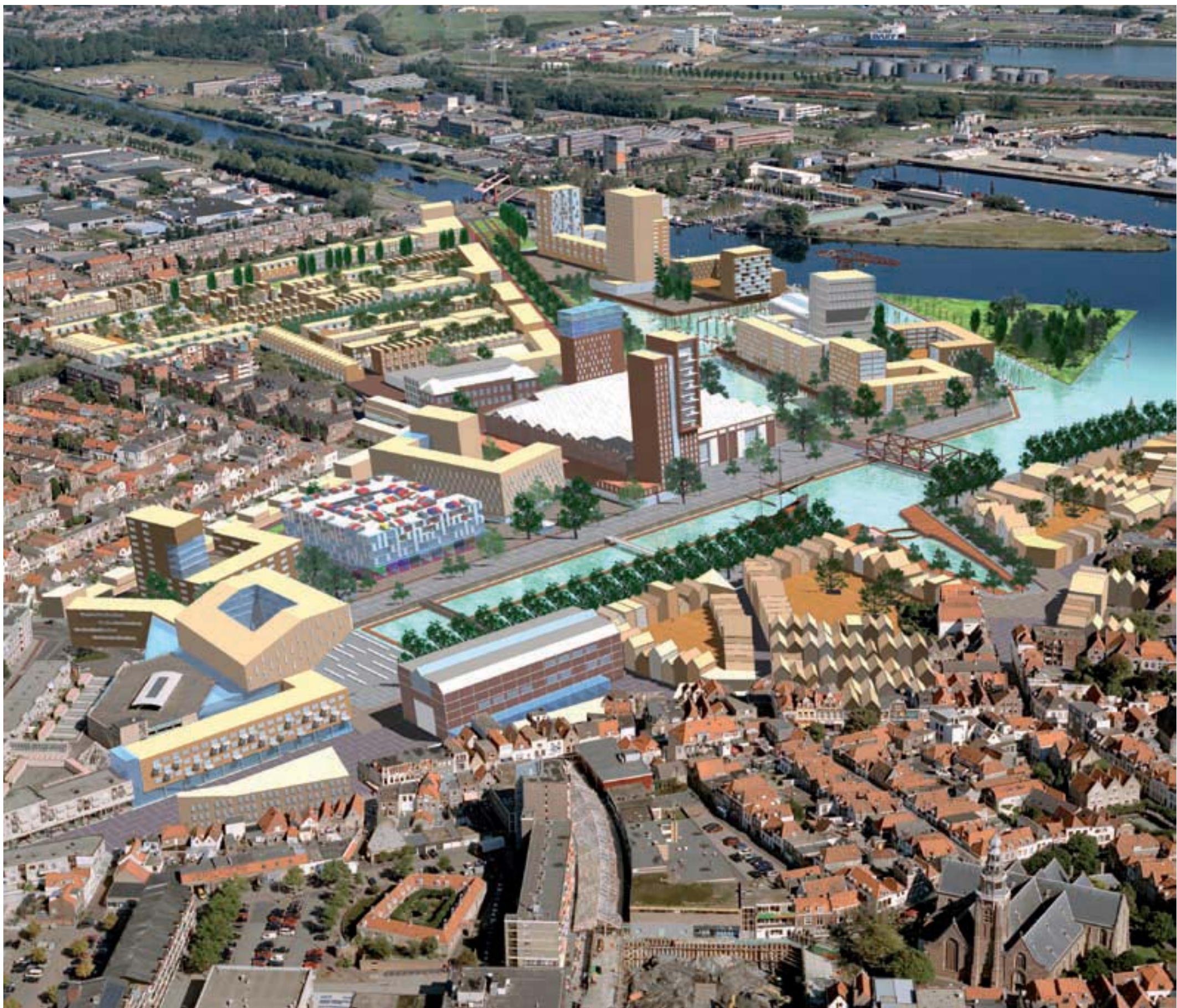
zicht op dok en haven
