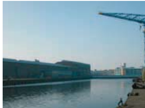
kades, kranen en bolders
