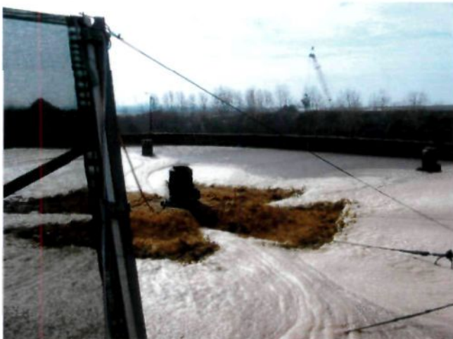
Figuur 10: Waterzuiveringsinstallatie bij Van Vliet Recycling
