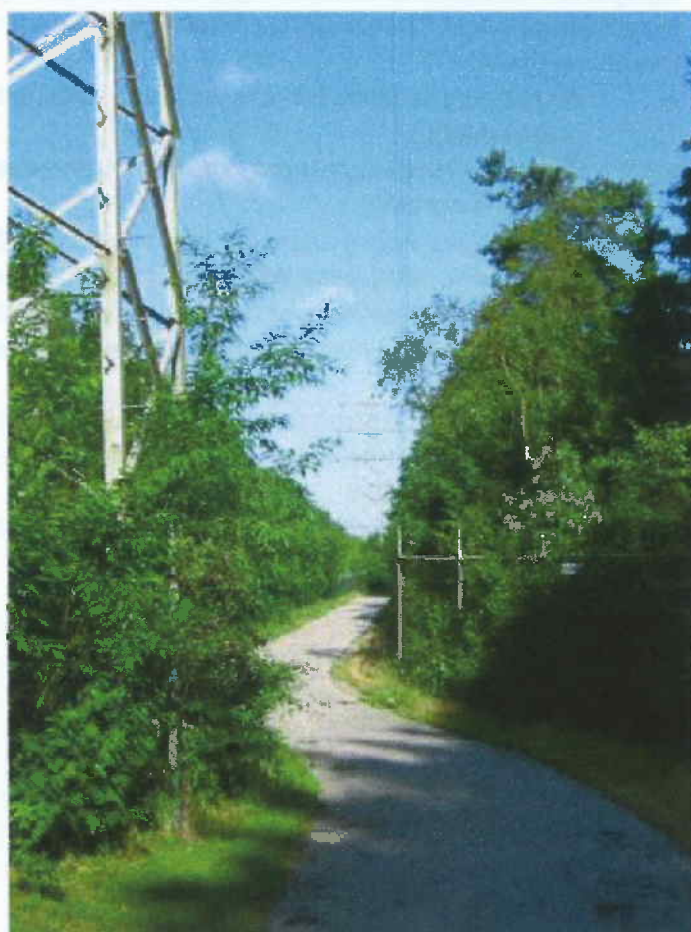
Hoogspanningsleiding langs zuidzijde plangebied
