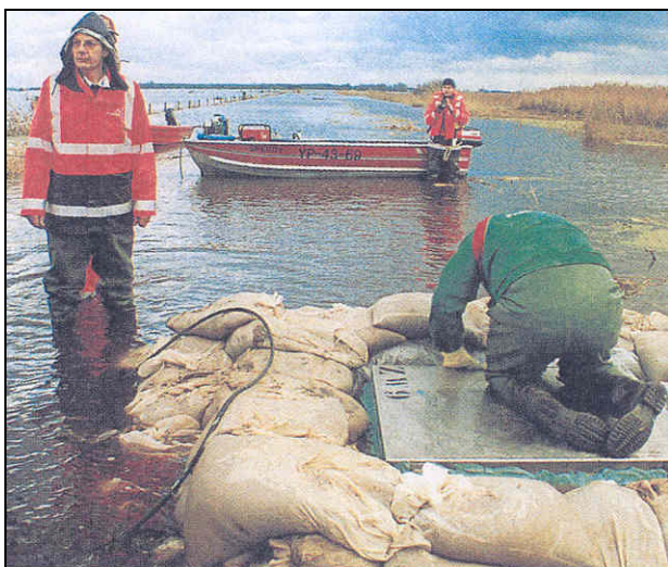
Afbeelding 1.1 Inundatie puttenveld pompstation Onnen (1998)
