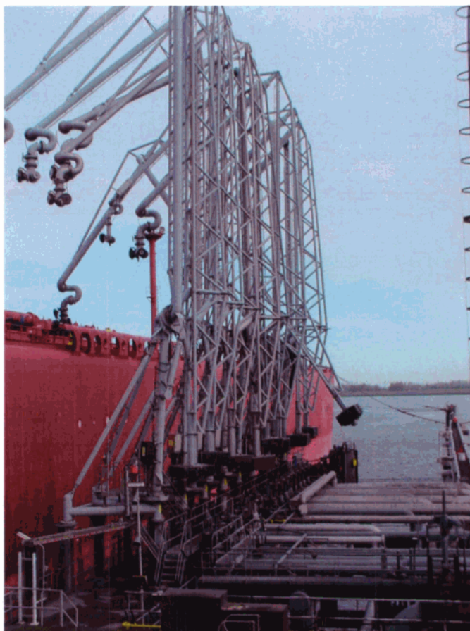
Foto 1: Laadarmen aangekoppeld aan schip
