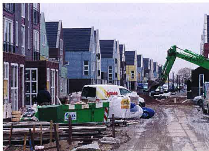
Werk in uitvoering in de wijk Bangert-Oosterpolder in de gemeente Hoorn. De Westfrisiaweg vormt de ontsluiting voor deze nieuwe woonwijk.
