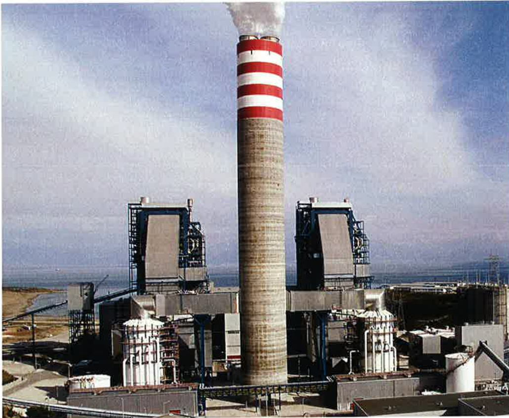
Figuur 3.1 Voorbeeld van zeewatergekoelde centrale (zonder koeltoren)
