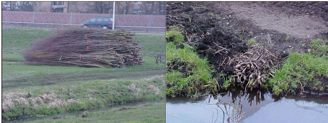
Figuur 2.14 Alternatieve drains bestaande uit samengebonden takken
