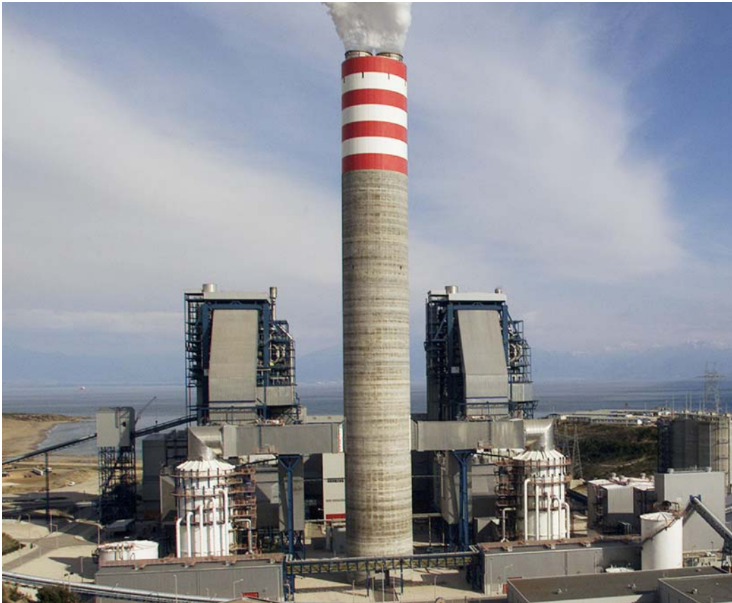
Abb 3.1 Beispiel eines Kraftwerks mit Seewasserkühlung (ohne Kühlturm)
