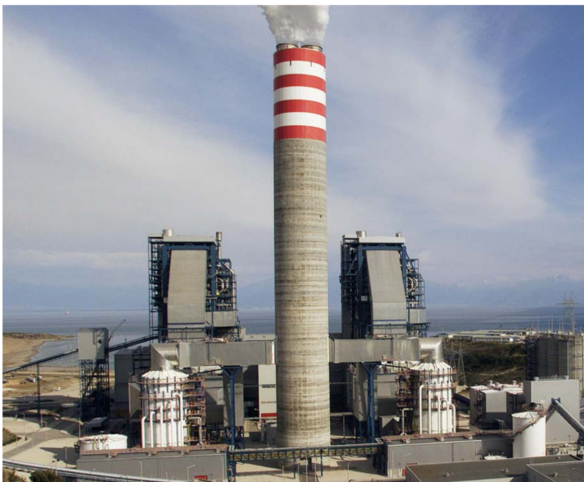
Figuur 3.1 Voorbeeld van zeewatergekoelde centrale (zonder koeltoren)
