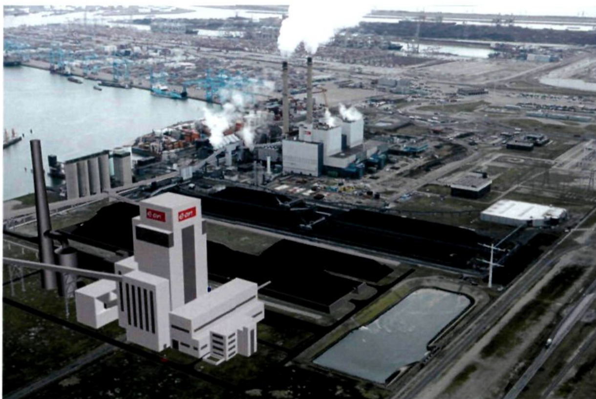
Figuur 3.1 MPP3 op het huidige terrein van centrale Maasvlakte
