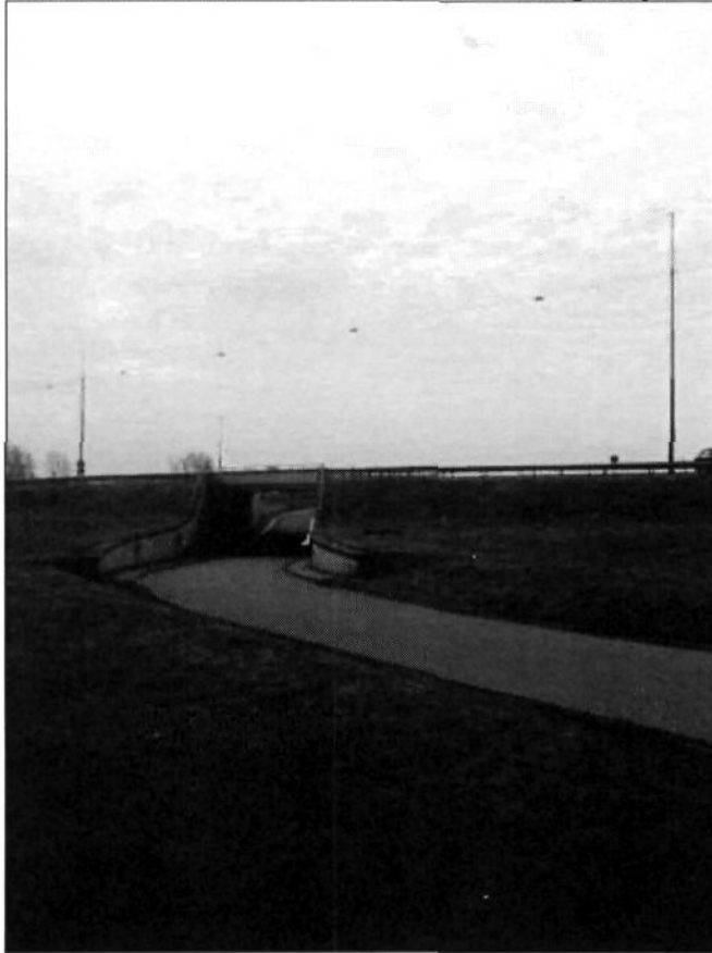
Foto: Tunnel onder de A9 ter hoogte van Fort Aagtendijk
