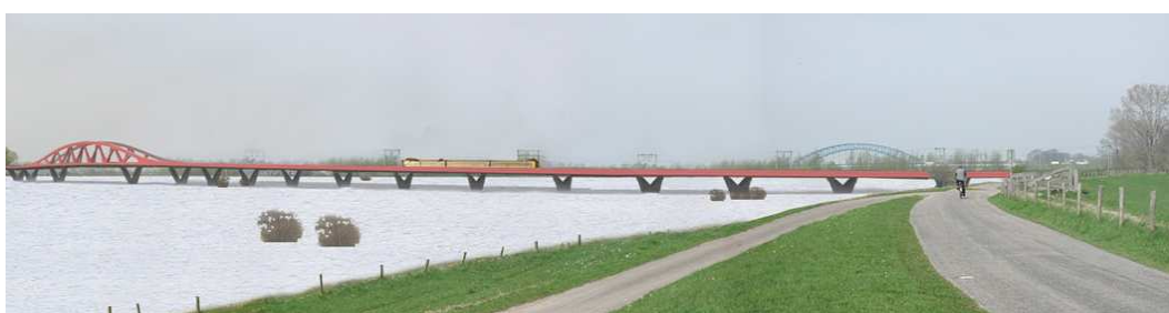
Figuur s4.1 Zicht op de spoorbrug in de huidige situatie en bij waterstanden van NAP+1,30 en 2,00m
