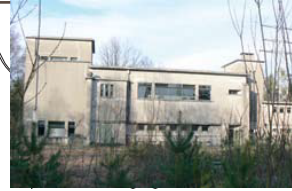
50 Kv Station + twee hoogspanningsmasten
