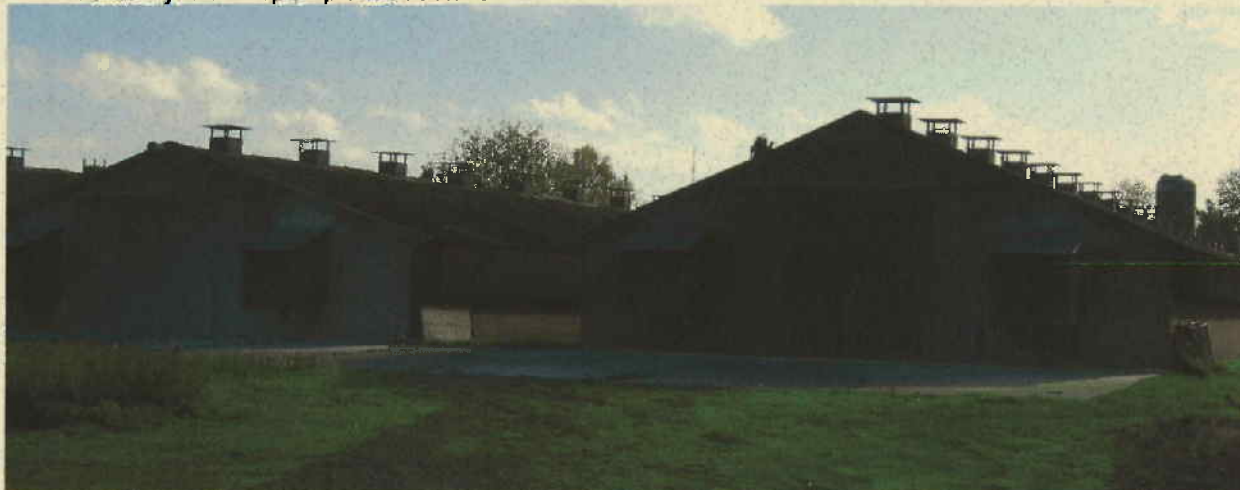
Foto: achterzijde te slopen pluimveestallen
