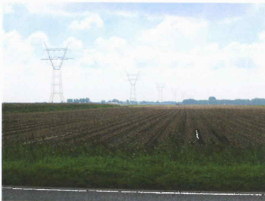
Plangebied vanaf N209 in zuidelijke richting
