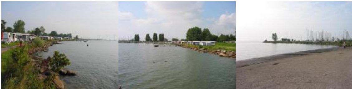
figuur 3.6 Noordelijke oeverstrook en havendam met stortmateriaal
