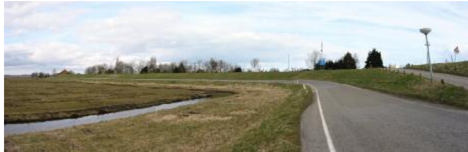
figuur 5.3 Beeld van de begroeiing op de achter de dijk gelegen camping, komend vanuit de richting Uitdam
