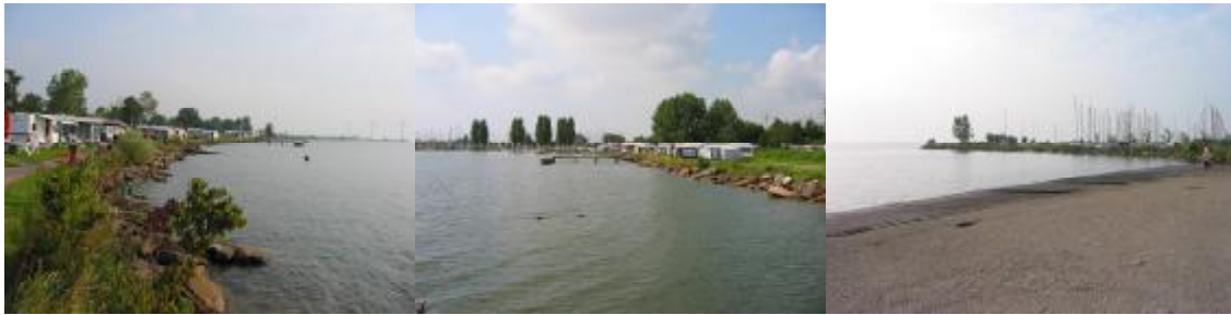
figuur 3.6 Noordelijke oeverstrook en havendam met stortmateriaal
