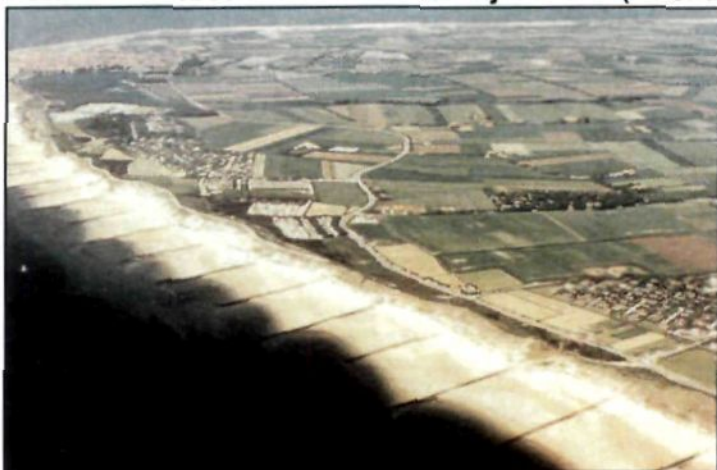
Foto 4.2. Voorbeeld dwarsdammen bij Monster (na onderhoud)
