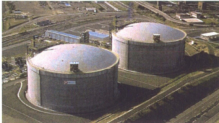
Figuur 2.5: Voorbeeld van twee LNG-opslag tanks in Portugal
