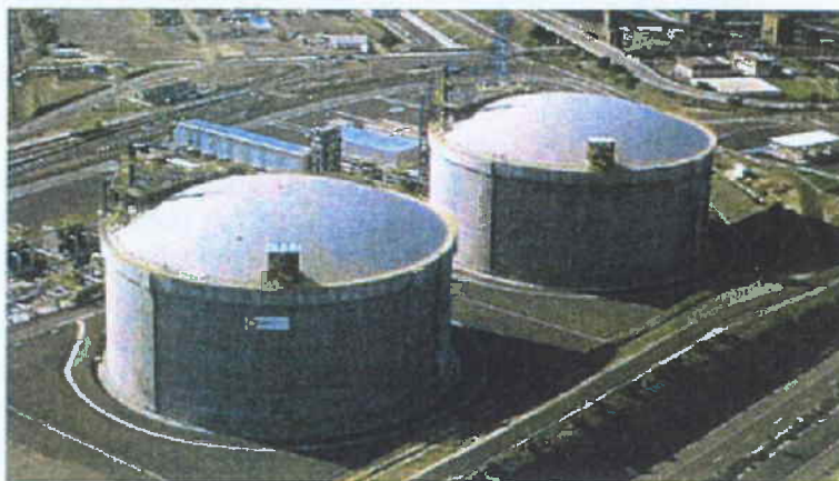
Figuur 4.8: Twee LNG-opslagtanks (Transgas Atlantico, Sines, Portugal) gebouwd in overeenstemming met NEN-EN 1473.
