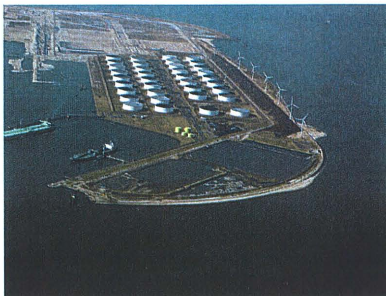
Figuur 4.1: Luchtfoto met daarop de MOT. De locaties van de LNG-terminal zijn links (terminalterrein) en onder (havenbassin) van de MOT gelegen [bron: 21].
