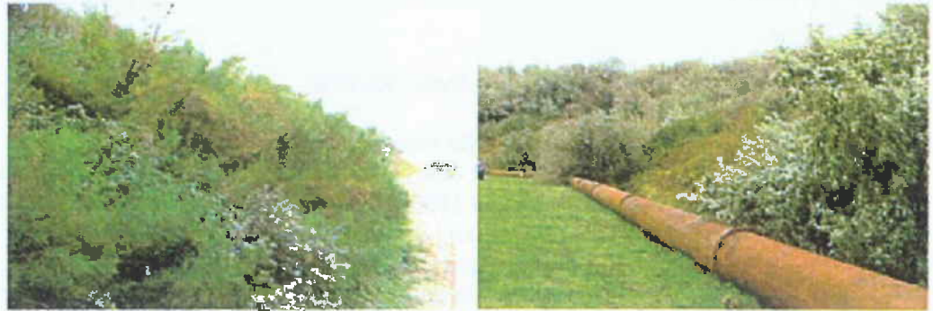
Figuur 6.3: Foto's uit november 2005 van de begroeiing van de Zuidwal [Bijl. 12, p. 8]. De leiding voor het verpompen van baggerspecie vanuit de Papegaaiebek naar De Slufter is zichtbaar.
