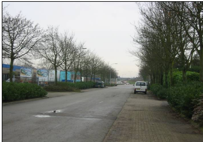
Einde van de huidige Randweg ter hoogte van de Rijnstraat
