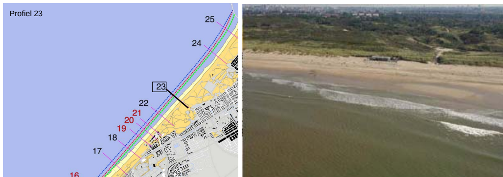
Figuur 5-17: Locatie profiel 23 Westduinpark. Op de foto is goed te zien hoe smal het huidige strand tussen hoogwaterlijn en duinvoet is.
