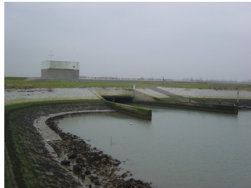
Foto: Spuisluis te Stellendam (buitenzijde)
