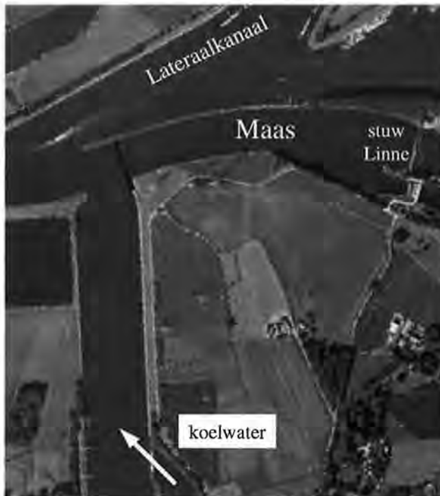
Figuur 4.2 Situatie koelwateruitlaat. De streep over de Maas geeft de dwarsdoorsnede waarover niet meer dan 25% een temperatuur boven 30 °C mag hebben
