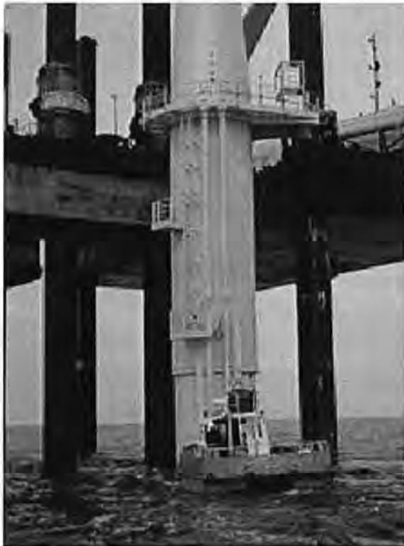
Figuur 4.2: Toegang turbine per boot (© Vestas) (BWEA, 2005)
