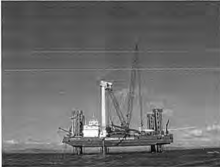
Figuur 3.5: Installatieschip de "Sea Jack" bij Arklow Bank als indicatie (Airtricity)
