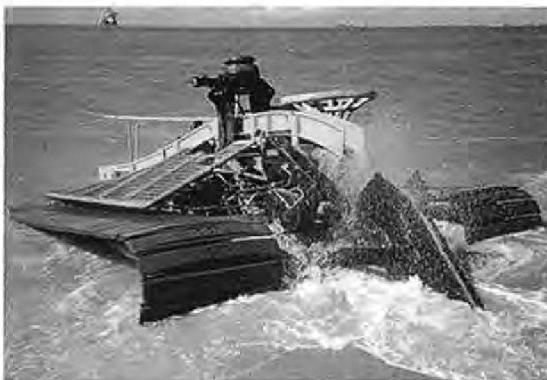
Figuur 3.6: Een installatie om kabels in te graven (Smarttrencher)
