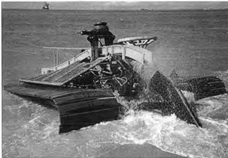
Figuur 4.6: Kabelgraver (Smarttrencher)
