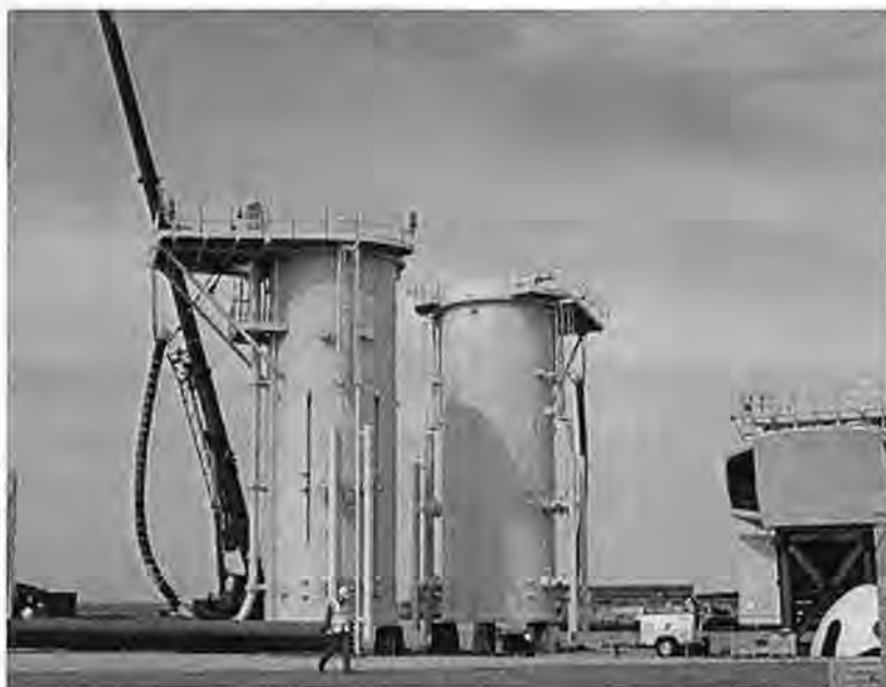
Figuur 3.3: Transitiestuk bij monopile
