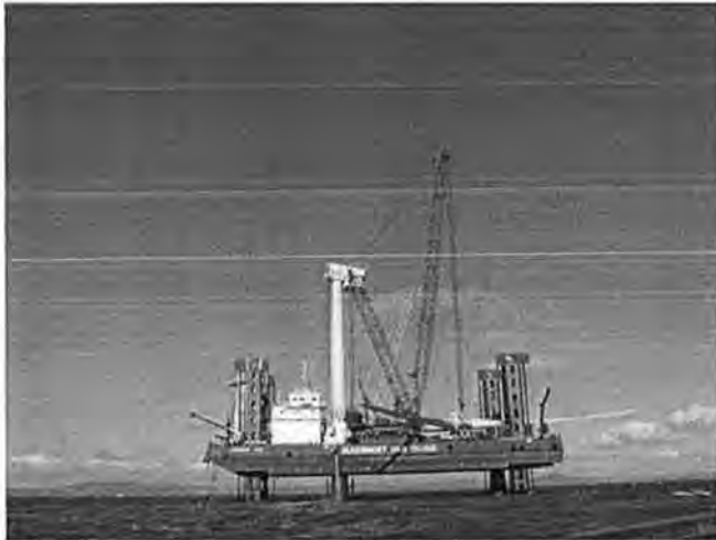
Figuur 4.5: Als indicatie van een installatieschip de "Jumping Jack" bij Arklow Bank
