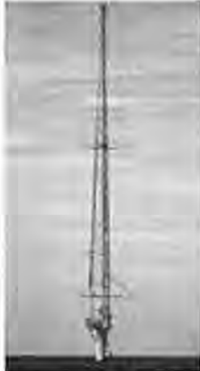
Figuur 3.2: Voorbeeld van een meetmast (meetmast van 116 meter hoog ten behoeve van het windpark OWEZ)
