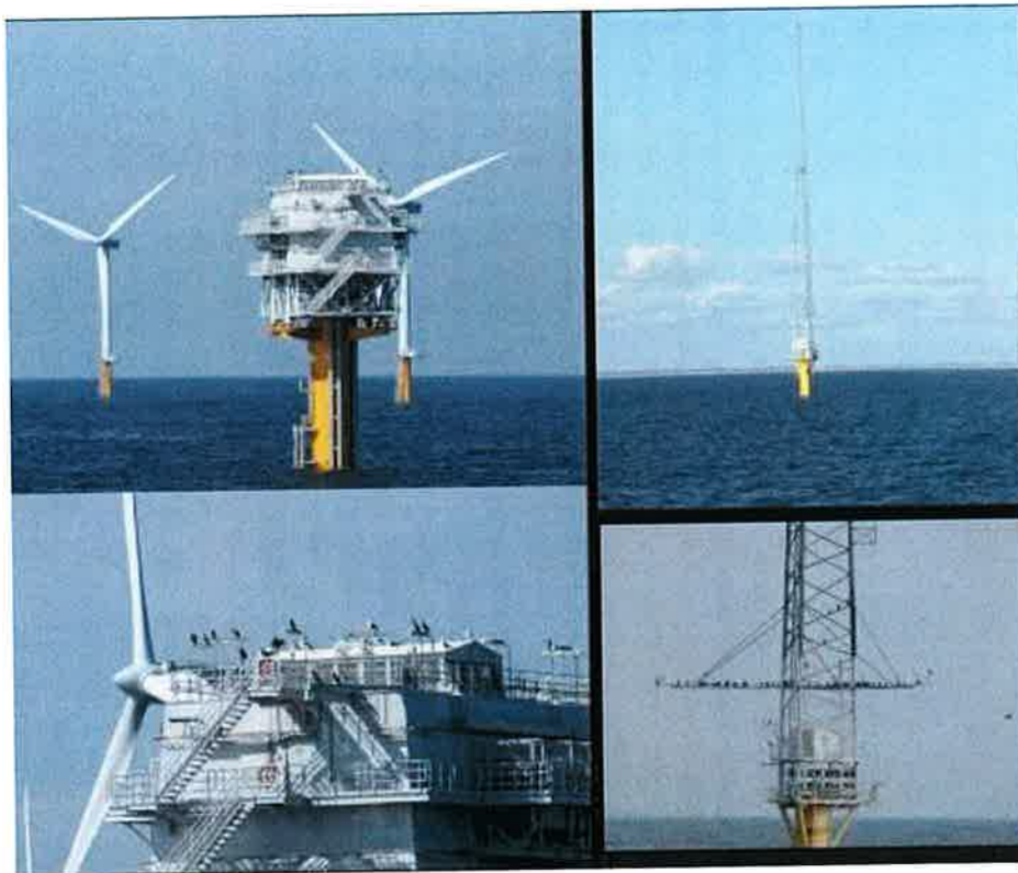
Figuur 4: Rustende Aalscholwers op het transformatorplatform van windpark Q7 (Prinses Amaliawindpark) (links, met linksonder een detail) en op de meteo-mast van windpark OWEZ (rechts, met rechtsonder een detail). Foto's Hans Verdaat.
