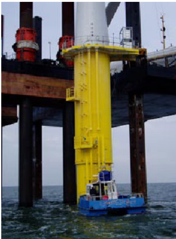
Figuur 4.2: Toegang turbine per boot (© Vestas) (BWEA, 2005)
