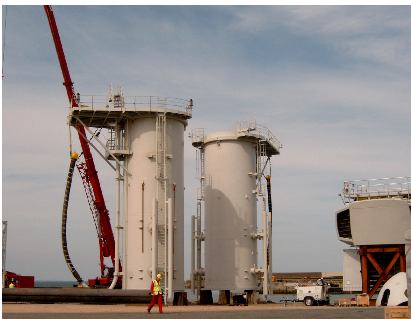
Figuur 3.2: Transitiestuk bij monopile
