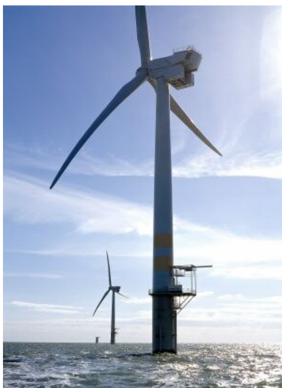
Figuur 4.1: Boven op de turbine, op de motorgondel, is een hijsplatform aanwezig
