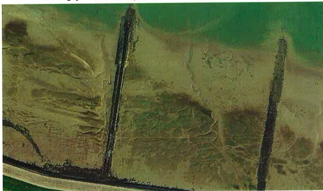
Figuur 4.2 Het buitendijkse intergetijdengebied ter hoogte van Perkpolder. Op de luchtfoto is duidelijk te zien dat delen van het intergetijdengebied uit laagdynamische slibrijke ecotopen bestaan.
