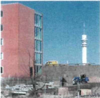
Figuur 9.1 Bouwactiviteiten bij het plangebied, hier voor de uitbereiding van het bestaande viaduct
