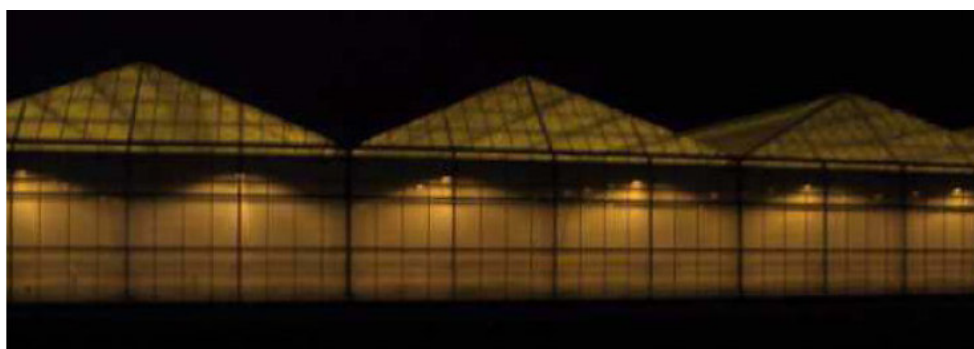
Figuur S.5: Breedkapkas met 95% afscherming aan de zijgevels en afgeschermd lampen (bron: www.platformlichthinder.nl )
