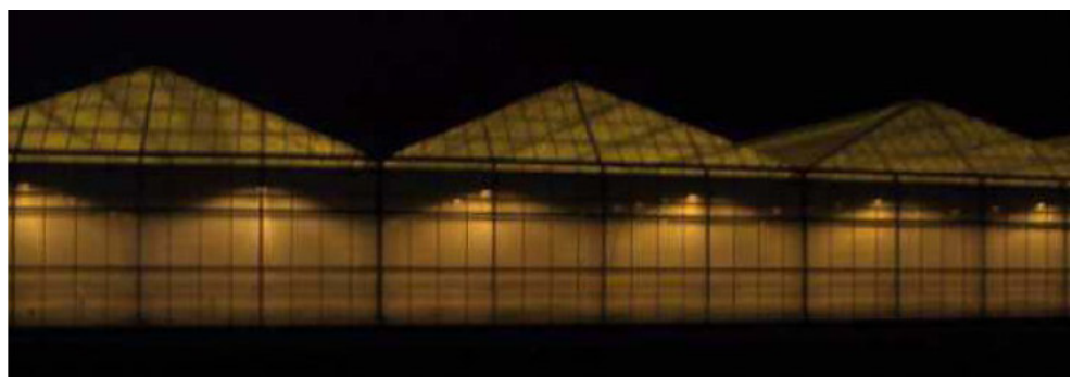
Figuur 8.8: breedkapkas met afgeschermdde lampen en 95% afgeschermdde gevels.
