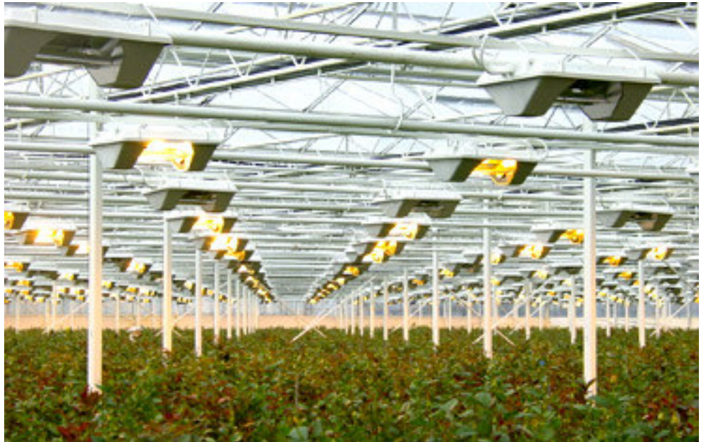
Figuur 8.6: assimilatieverlichting in glastuinbouw
