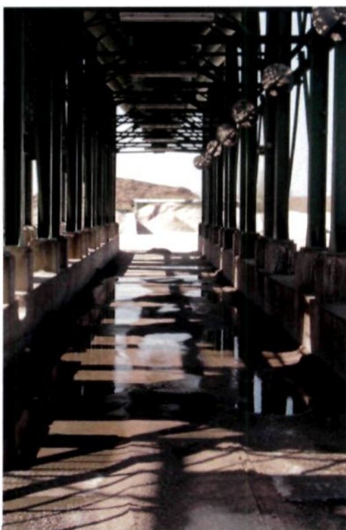
12. Laadruimte vrachtwagens onder verlaadsilo's
