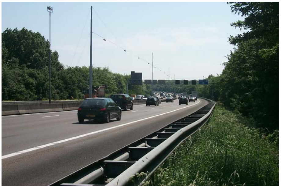
Het Amsterdamse bos: een duidelijk herkenbaar deel van de A9
