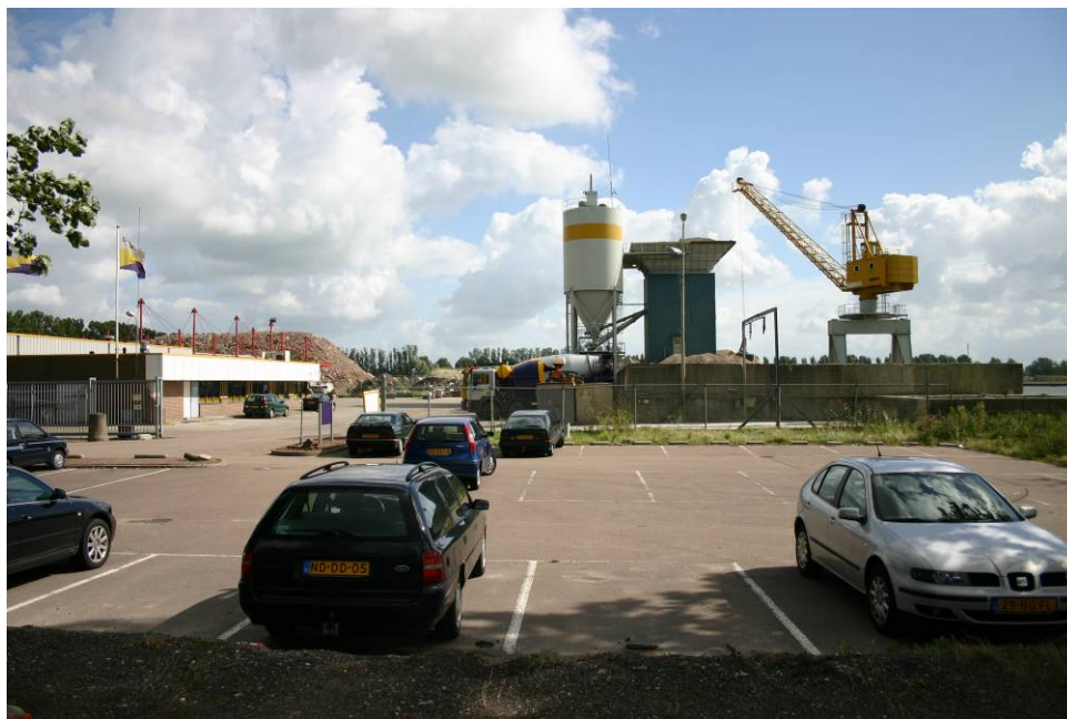
Figuur 3.3 Industrieterrein De Schelphoek met op de achtergrond groothandel bouwmaterialen BBN en betonmortelcentrale BEMOG.
