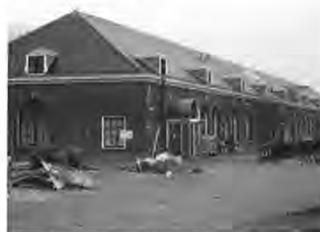
gebouw op Cape Holland Willemsoord
