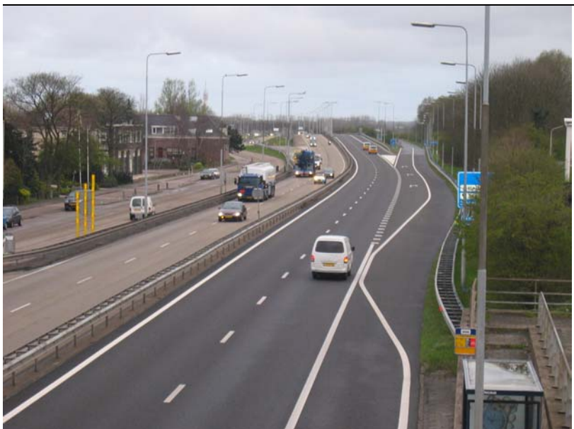
Figuur 4.2 A200 langs het plangebied, met rechts de afslag naar het tankstation
