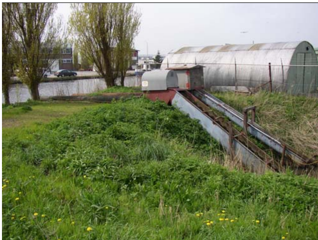
Figuur 6.1 Gemaal Zwetpolder
