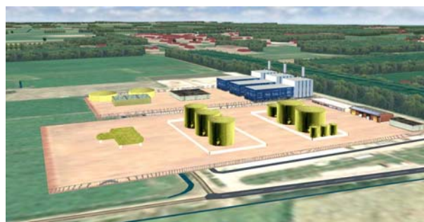
Figuur 16: Impressie van centrale behandelingsinstallatie gecombineerd met faciliteiten voor stoomgeneratie aansluitend bij de voormalige oliebehandelingsinstallatie.
